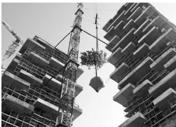
Рис. 7. Процесс строительства «вертикального леса» в Милане
